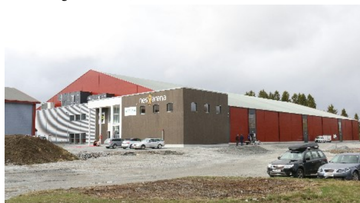
Slik ser den nye hallen ut fra utsiden.
